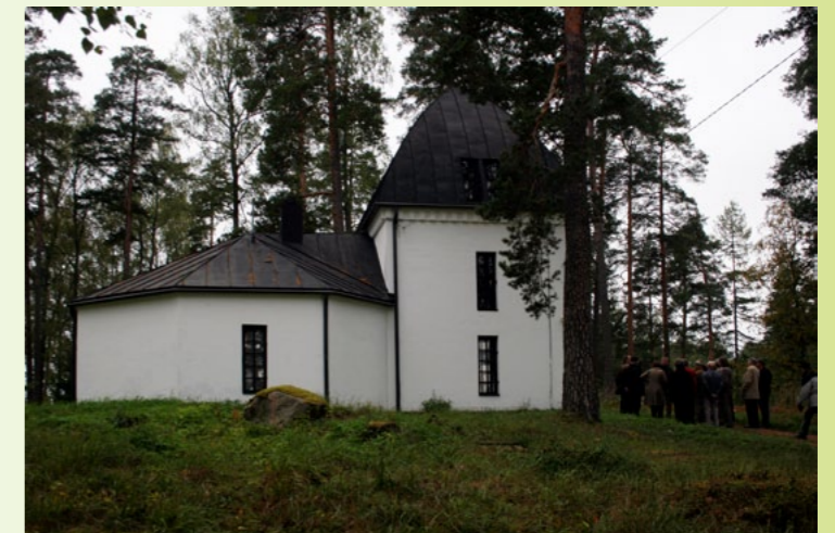
Tässä rakennuksessa oli Santamäen kartanon vesivasto.
