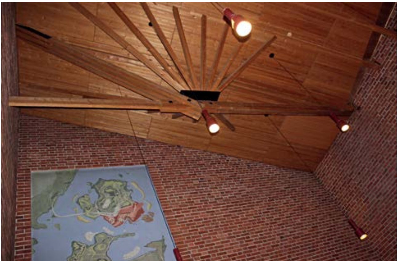
Säynätsalon kunnantalon kattorakennetta. Seinällä kartta, jossa Säynätsalo ja sen alapuolella Lehtissaarta ja Muuratsalon pohjoiskärki.
