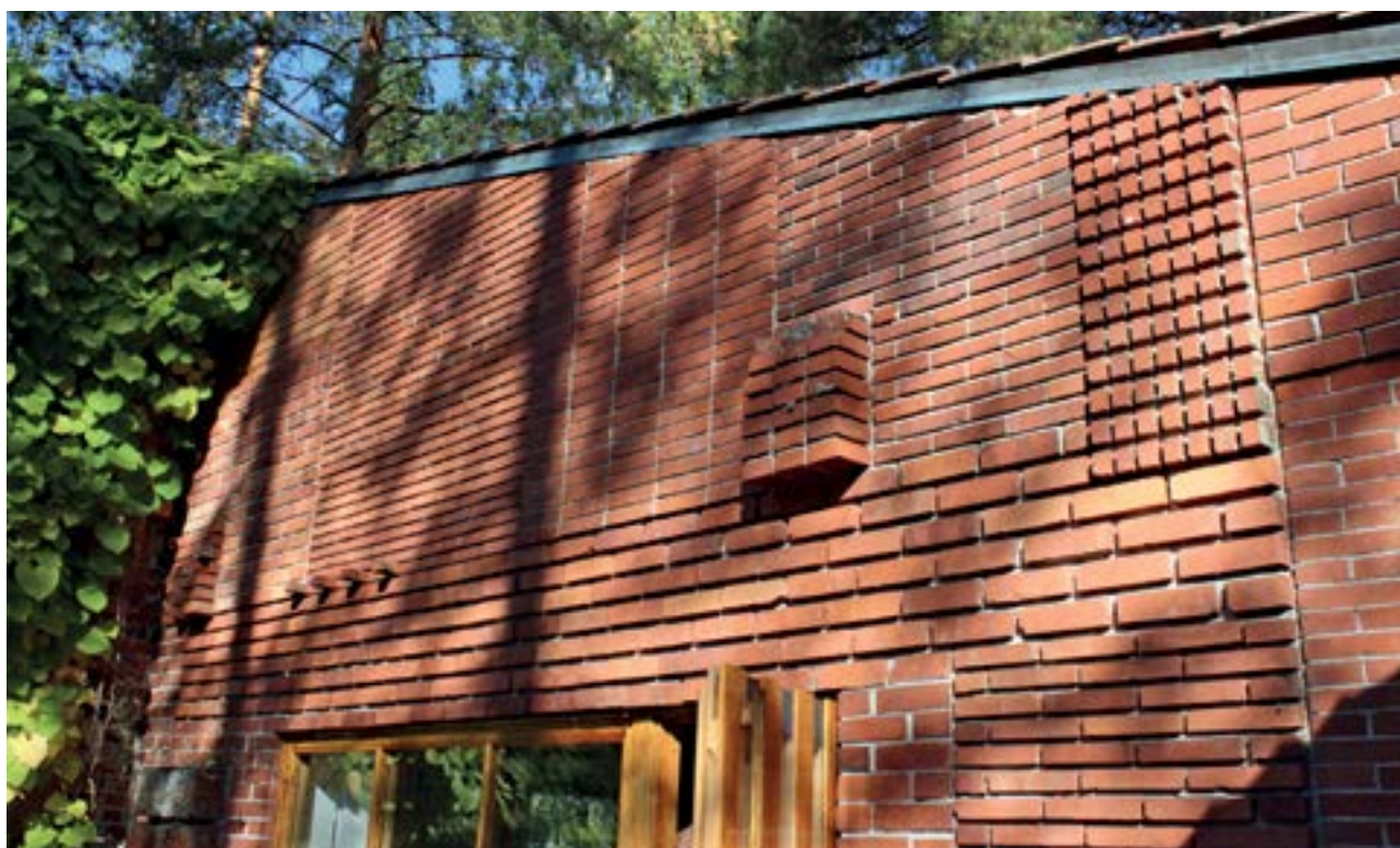
Tiili- ja rakennemalleja Muuratsalon koetalon seinässä.
