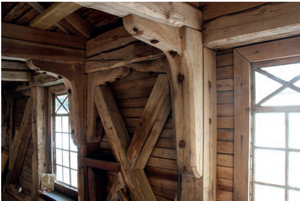
Kuusen juurakoista muotoiltuja rakenteiden tukia Makkarakosken sahassa. Kuva: Antti Koskimäki.
