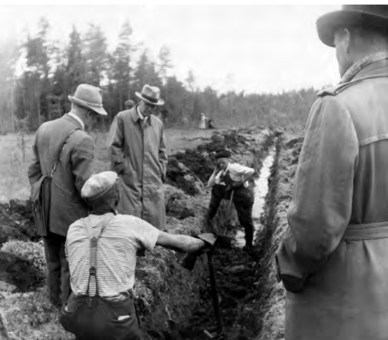
Urho Kekkonen tutustuu ojitustyömaahan Isojoella oikealla puolellaan Seinäjoen metsänparannuspiirin päämetsänhoitaja Akseli Suominen. Kuva on otettu ajanjaksolla 1956–1959. Kuva on Esko Lahden arkistosta.
