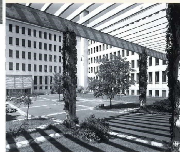
Portina Unioninkadulta Metsätalon pihalle on kevyt pergolarakenne, joka on vastakohtana massiivisille ja korkeille rakenteille. Alun perin Metsätalon seinät olivat valkoiseksi rapatut. Pihalla näkyy sahattuja tukkeja.
